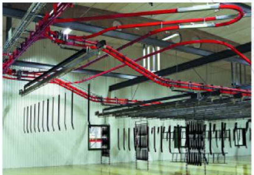
Zone de stockage sur voies parallèles avec dénivelé
