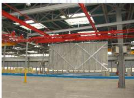
Transbordeur avec poutre roulante
